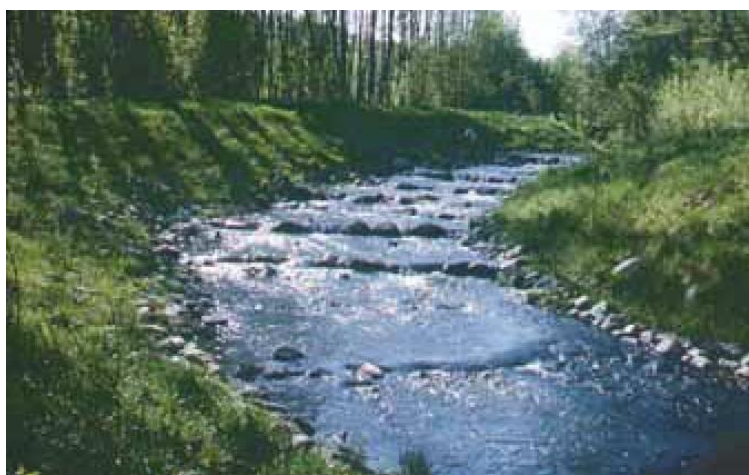
Figura 2.1.1 – Esempio di un canale by-pass per l'ittiofauna realizzato.
